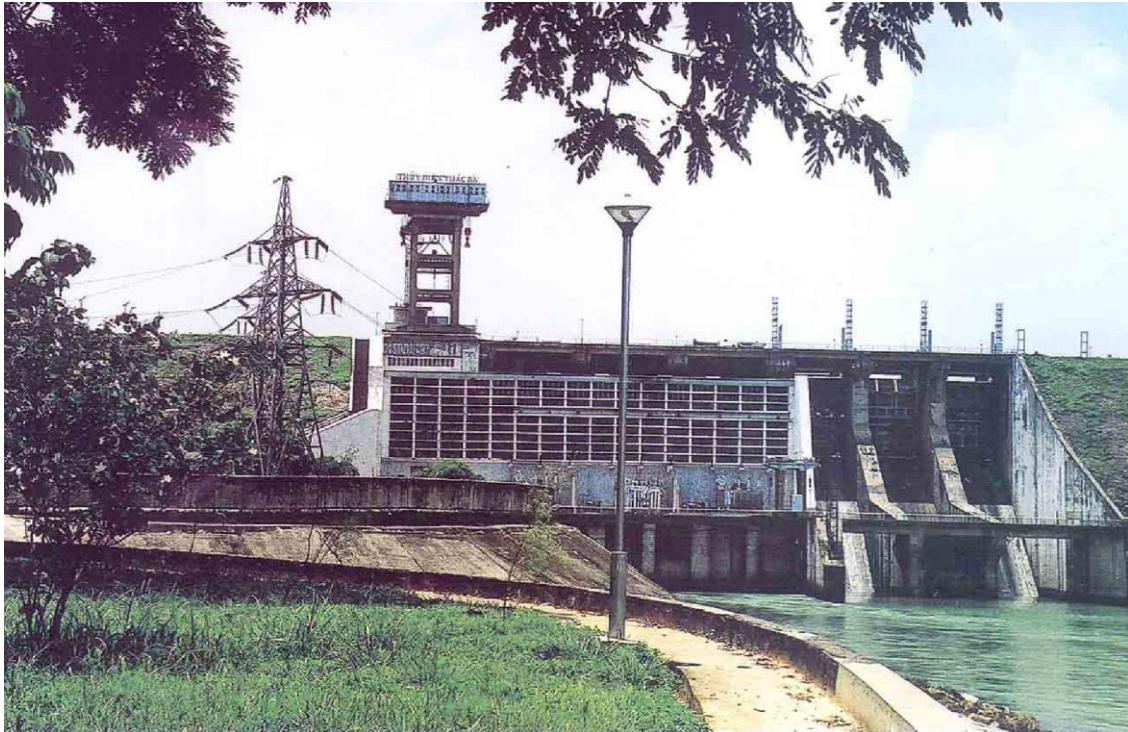
Hình 2. Nhà máy thủy điện
