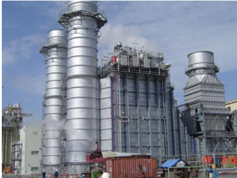
Hình 1. Nhà máy nhiệt điện
