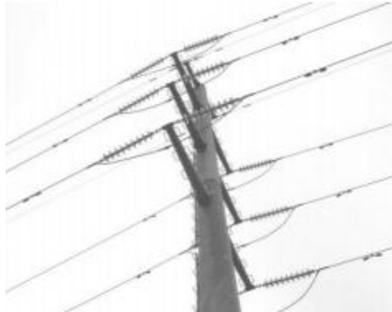
Vị trí lắp bộ chống rung
