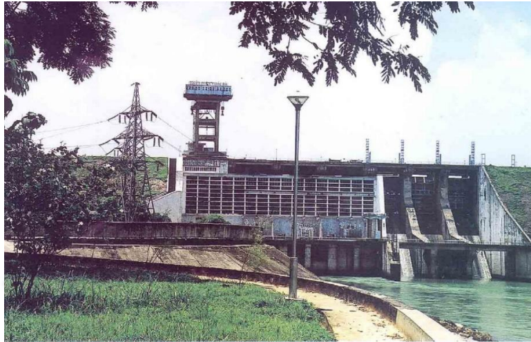
Hình 1- 2. Nhà máy thủy điện
