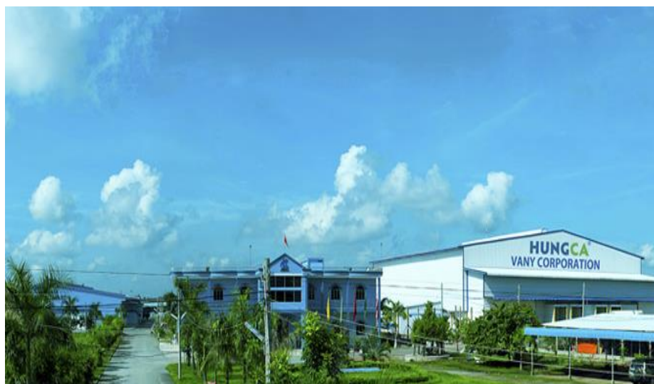
Hình 1.1. Nhà máy Hùng Cá và nhà máy Vạn Ý tổng công suất 370 tấn nguyên liệu/ngày
