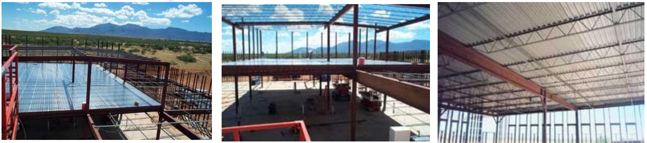
Hình 1.1. Khung nhà bằng thép trong xây dựng
