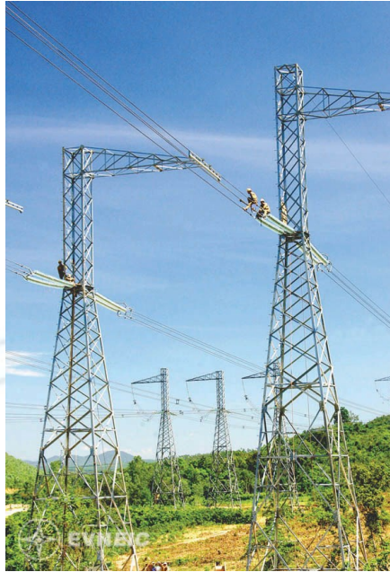
Xây dựng đường dây siêu cao áp 500 kV
