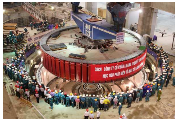
Lắp Roto thủy điện Sơn La 20/8/2010 400MW-1000tấn, R=15,8m, H=3,2m
