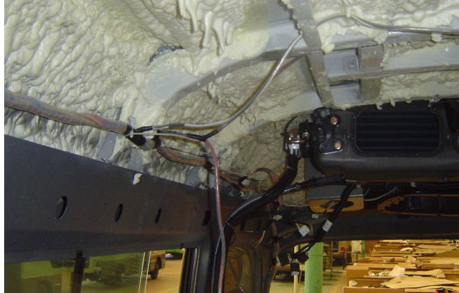
Hình 4.3. Đi dây điện bọc vỏ phía trong
