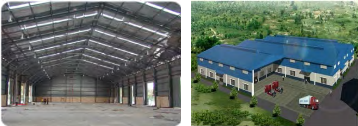
Hình 2.1.11. Hệ thống thông gió tự nhiên
