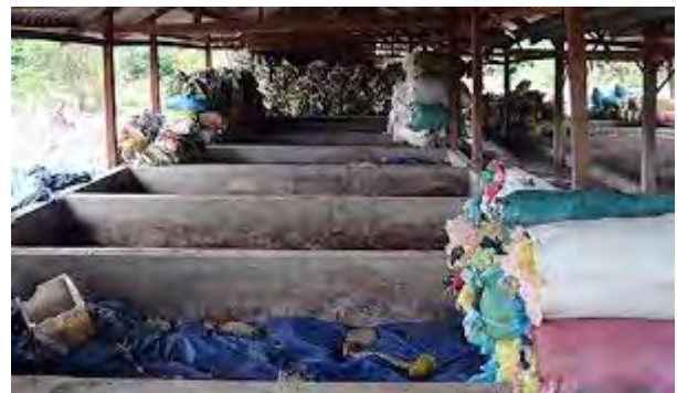
Hình 2.1.5. Xây từng hố kín
