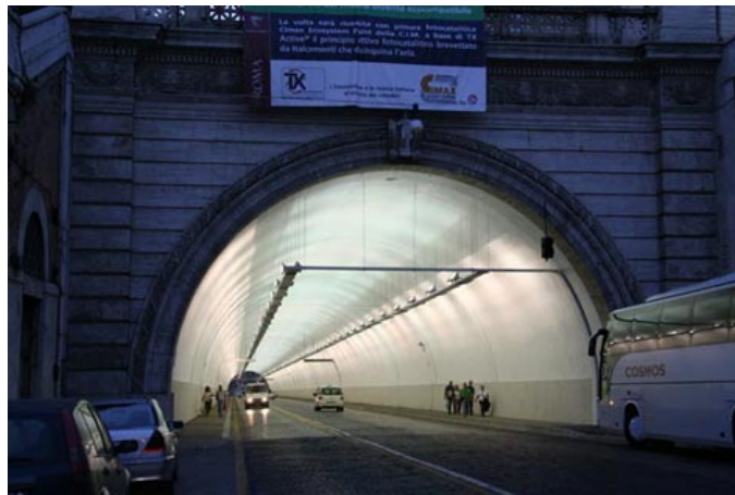
Hình 1.7. Đường hầm Umberto I – Rome (2007)
