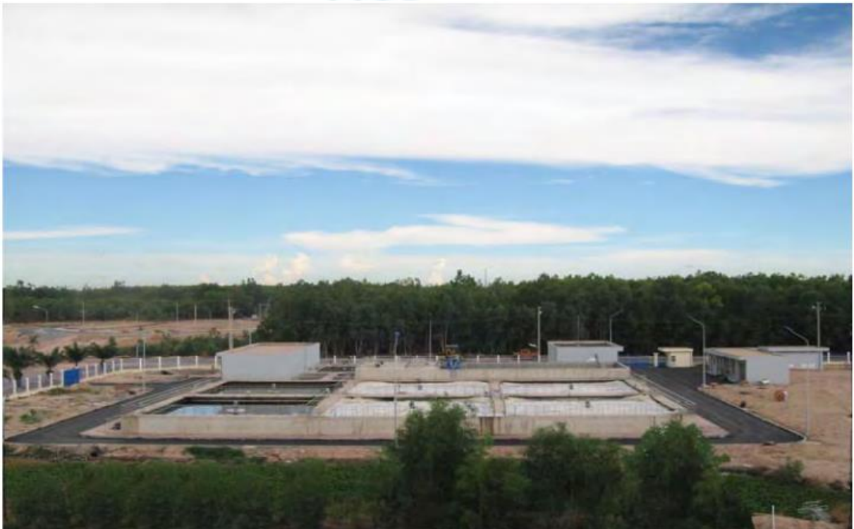
Hình 1.1: Khu xử lý nước thải KCN Quế Võ – Bắc Ninh
