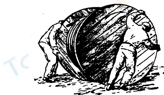
Hình 2.2.Lăn vận tang lô cáp
