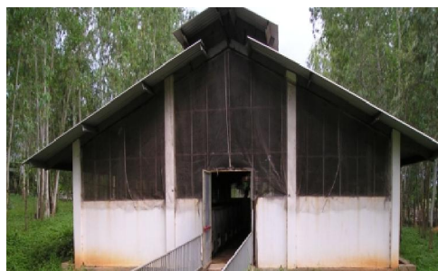
Hình 2.5. Mái chuồng làm bằng tôn (mái đơn và mái kép)
