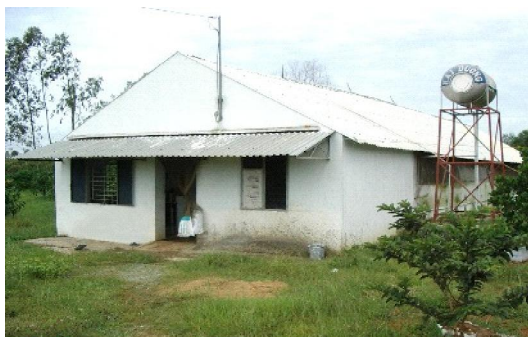
Hình 2.5. Mái chuồng làm bằng tôn (mái đơn và mái kép)
