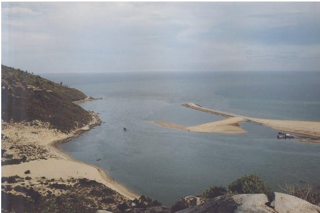
Hình 1.: Doi cát gần đầu đê chắn ngang 2/3 luồng tàu ra vào cửa Đê Gi
