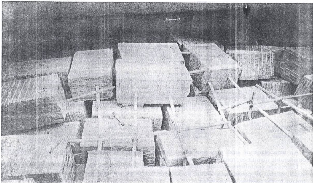
Hình 1.2 Chất xếp đá khối Granit trong hầm
